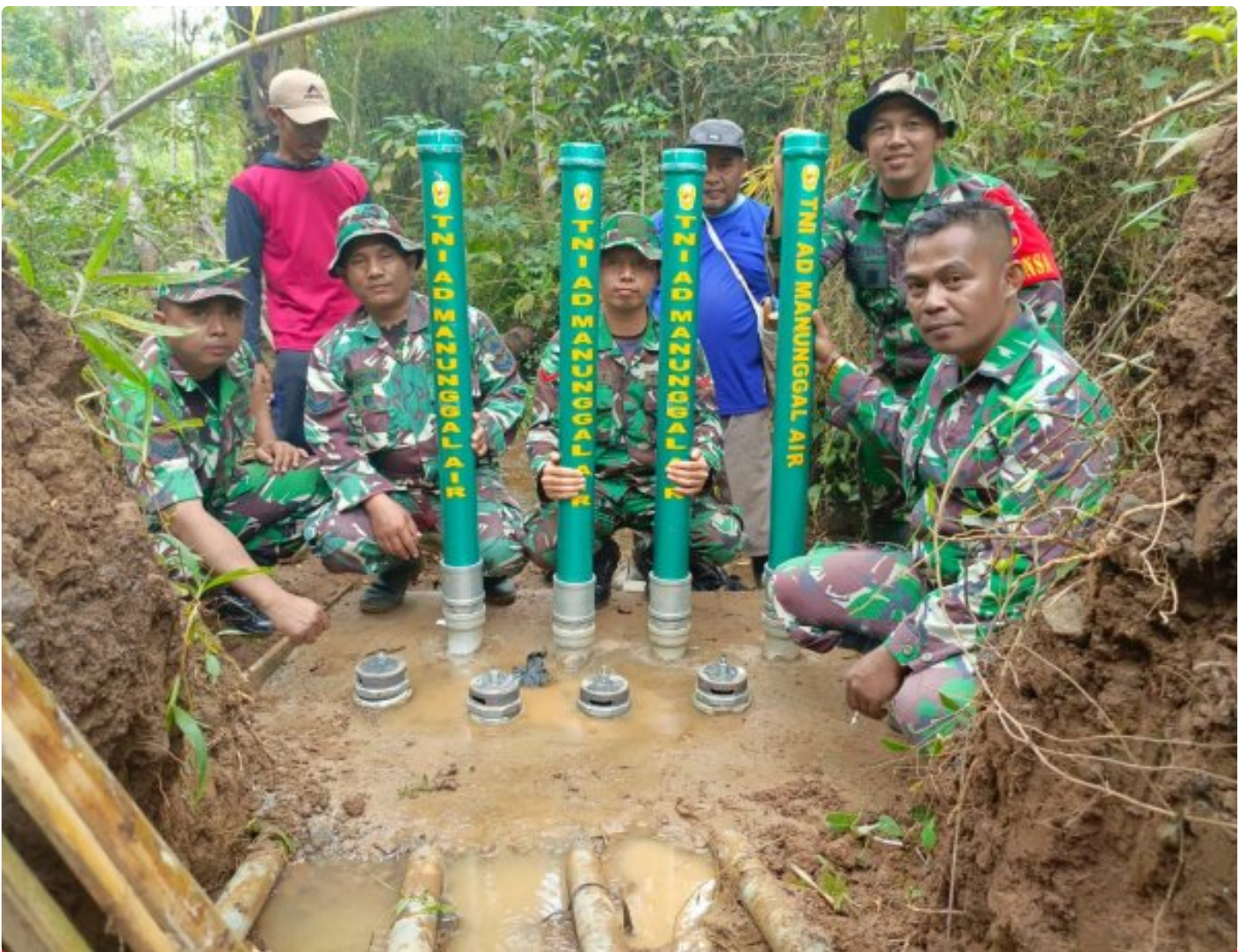
Foto; Pembuatan Pompa Air Hidran di Dusun Kalisalam Sukses Dilaksanakan
